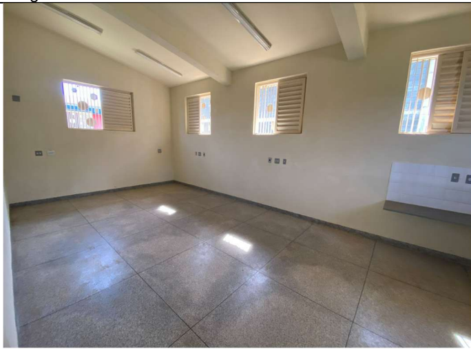
Foto 02 – Visão geral de uma das salas de oficina
