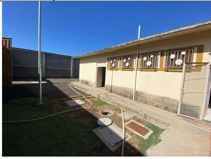
Foto 02 – Fachada externa do setor
