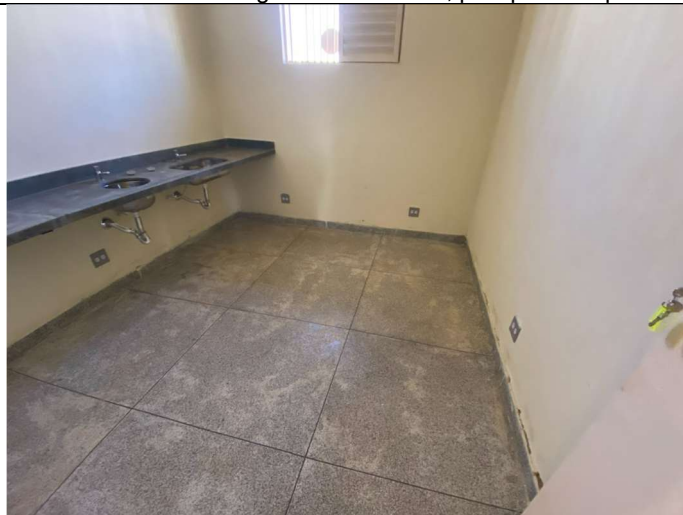
Foto 12 – Sala com bom aspecto nas paredes
