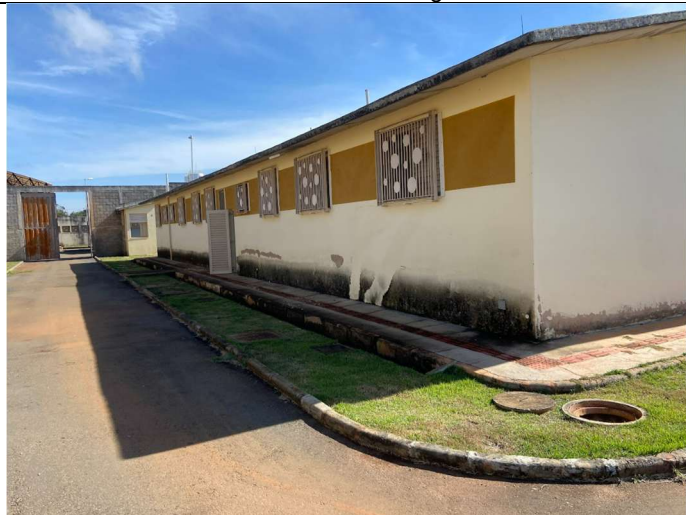
Foto 01 – Fachada externa do setor
