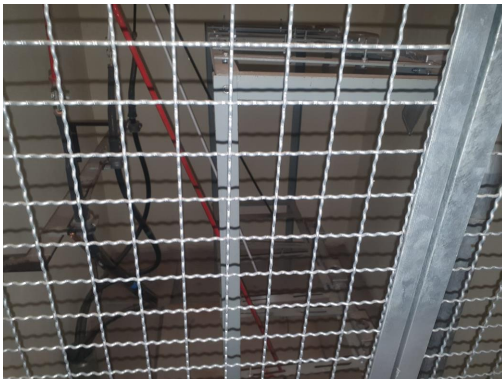
Imagem 2:local onde ficaria os trafos da subestação
