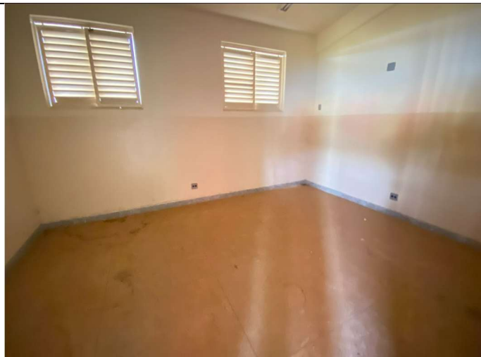
Foto 02 – Sala de aula
