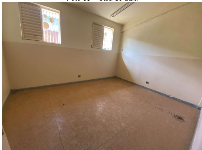
Foto 11 – Sala de aula
