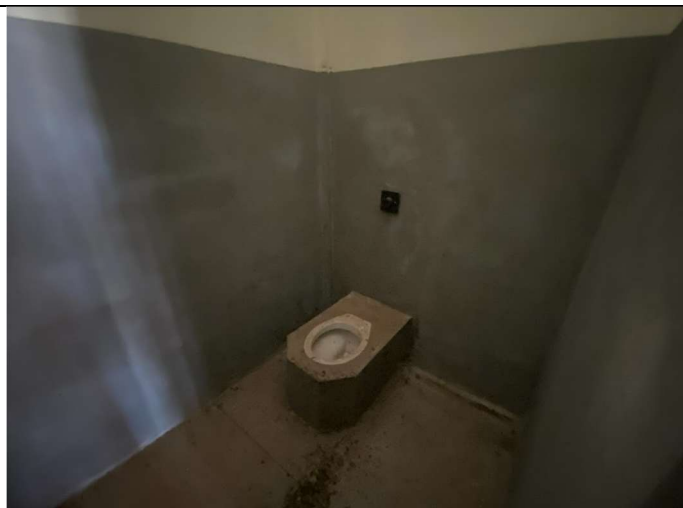
Foto 08 – Banheiro do prédio
