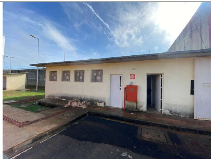
Foto 05 – Prédio da portaria (entrada)
