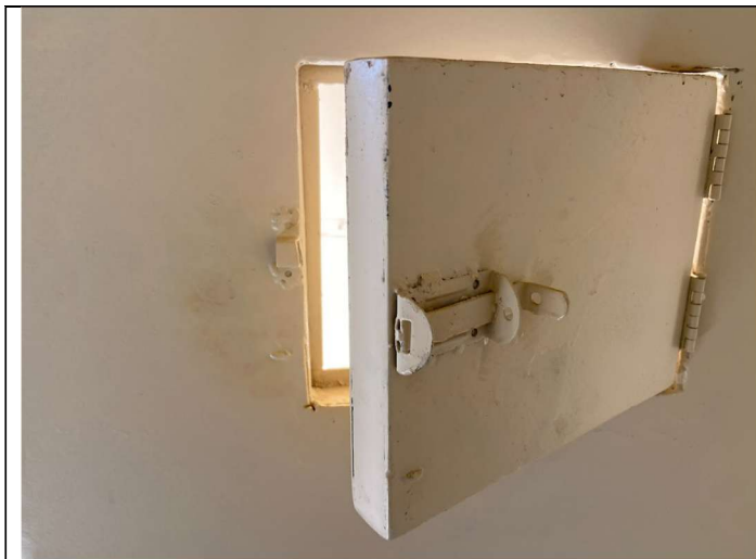
Foto 13 – Exemplo de visor “abre-fecha” a ser trocado
