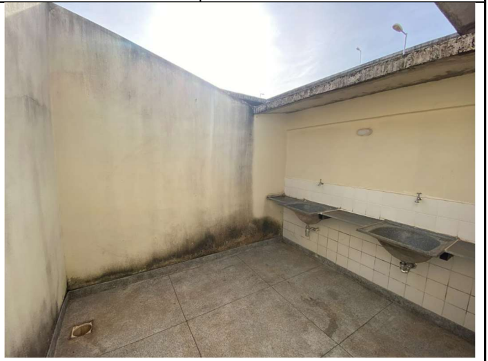
Foto 08 – Área de lavanderia
