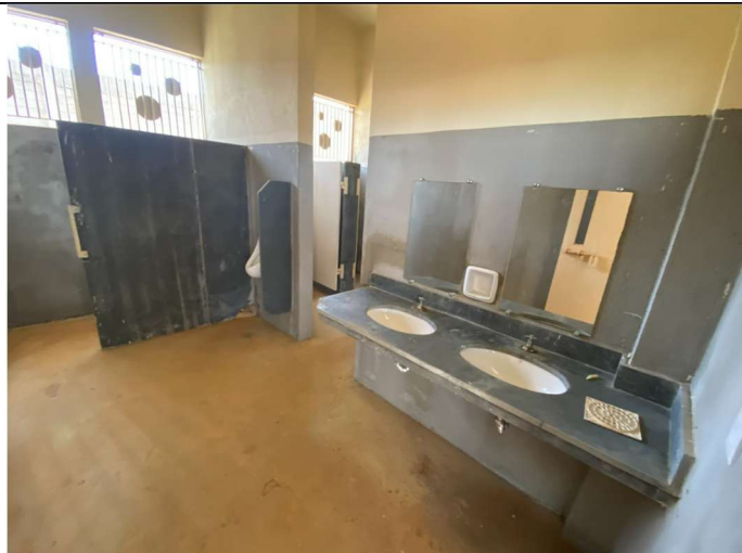
Foto 04 – Visão de banheiro coletivo
