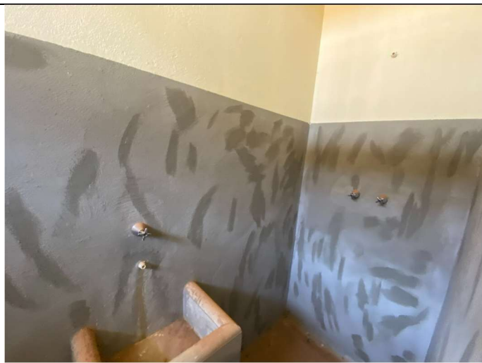
Foto 08 – Visão geral de banheiro do alojamento
