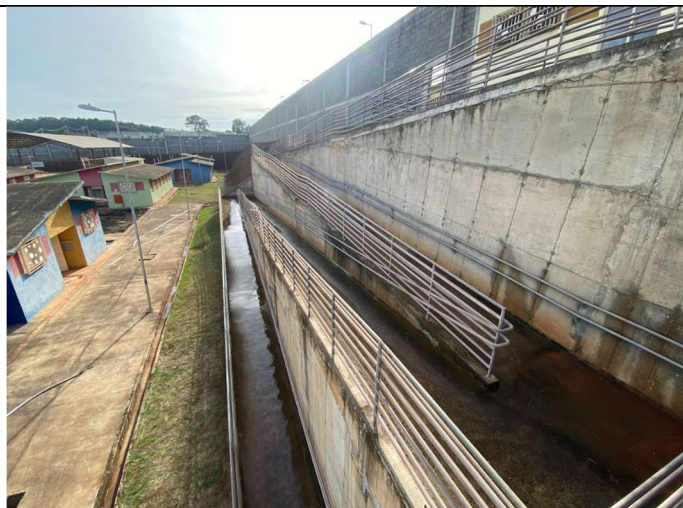
Foto 06 – Visão detalhada de rampa entre os platôs
