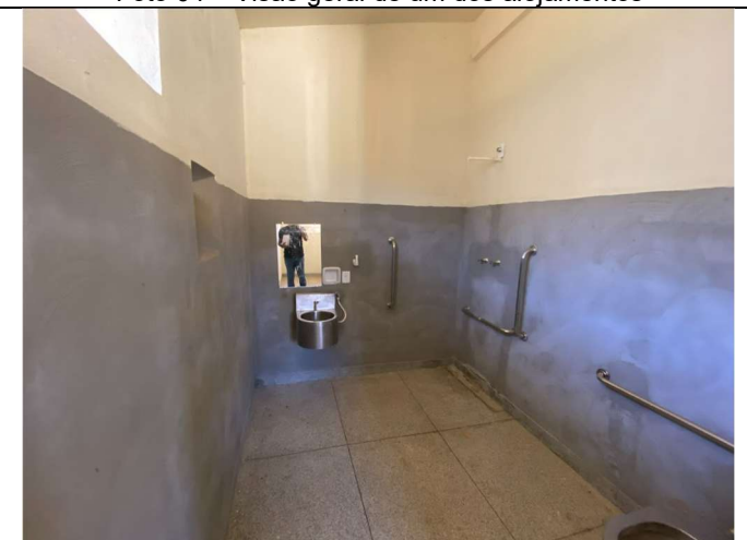
Foto 06 – Visão geral de banheiro do alojamento
