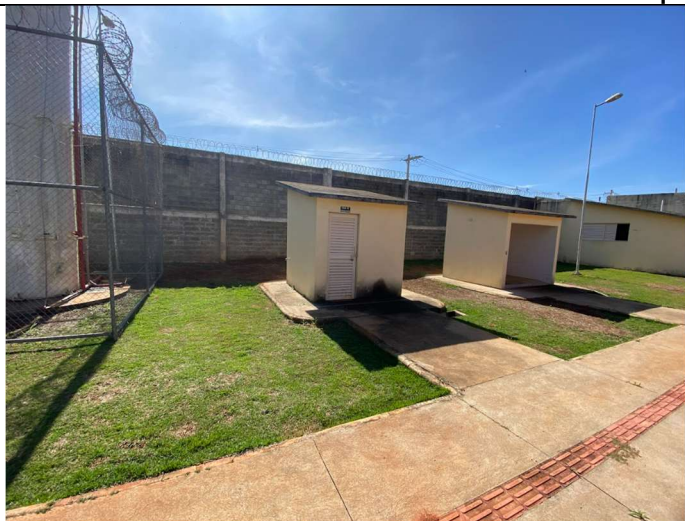
Foto 01 – Prédio casa de máquina e lixo
