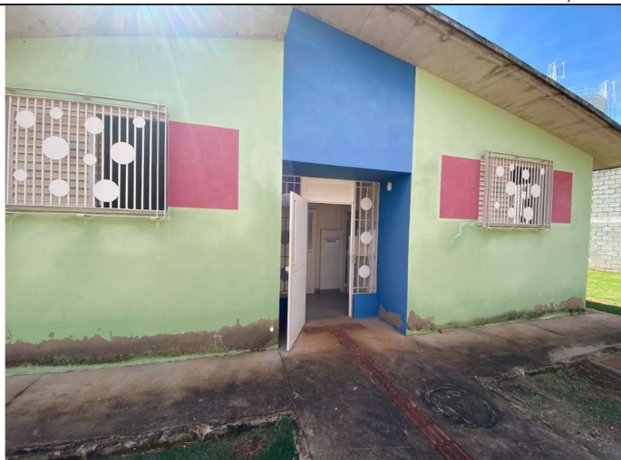
Foto 01 – Fachada do prédio
