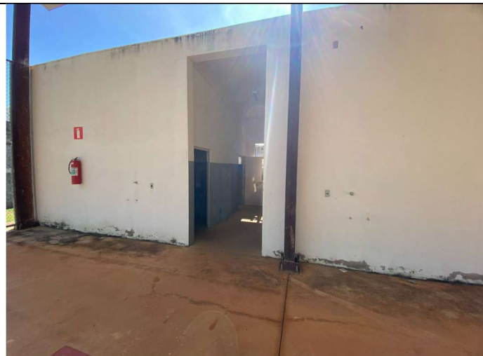
Foto 01 – Visão de fachada dos vestiários
