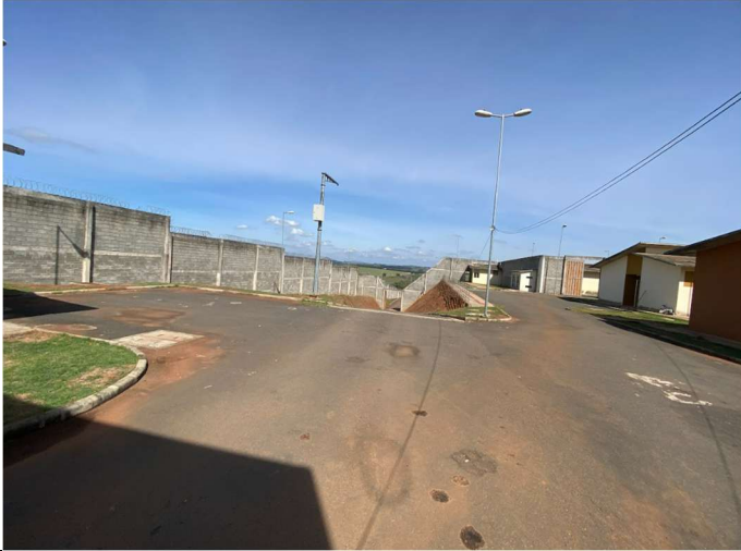
Foto 01 – Visão geral do platô superior da Unidade
