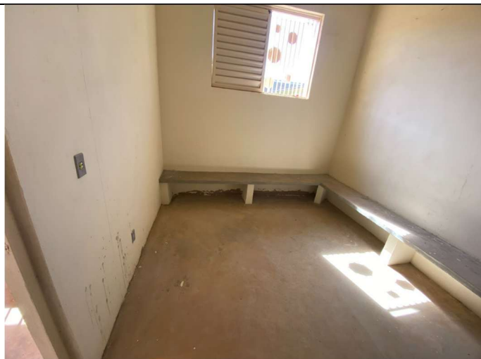
Foto 04 - “Sala de TV” do bloco
