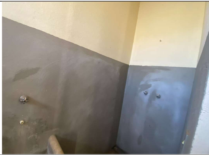
Foto 05 – Banheiro geral de alojamento
