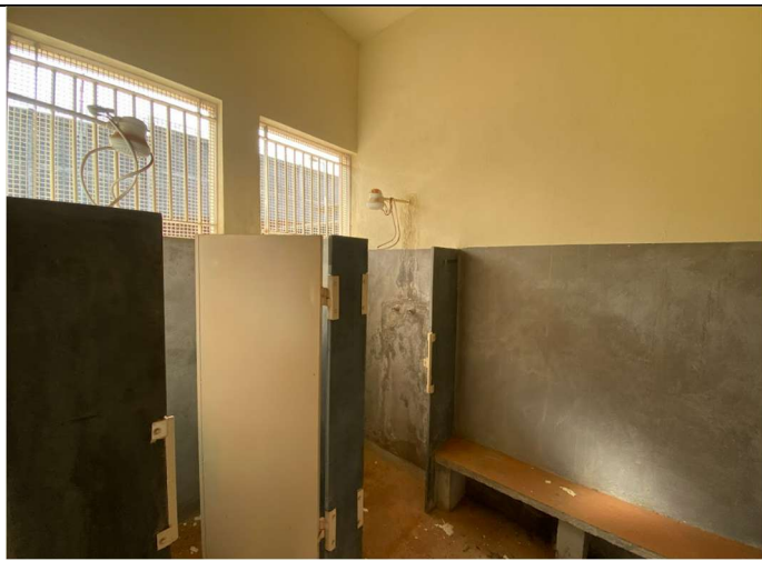
Foto 03 – Visão geral do banheiro
