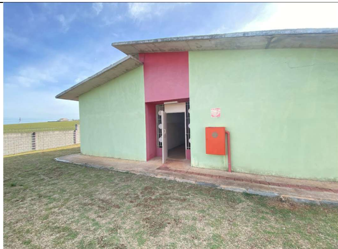
Foto 01 – Fachada do prédio
