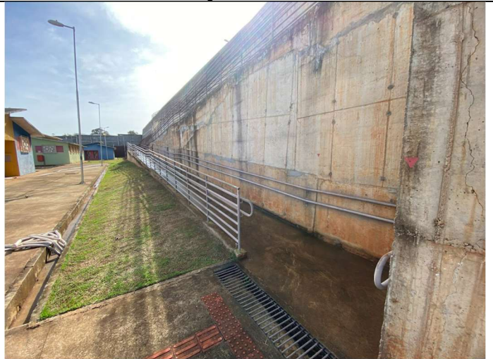
Foto 04 – Visão geral de rampa entre os platôs
