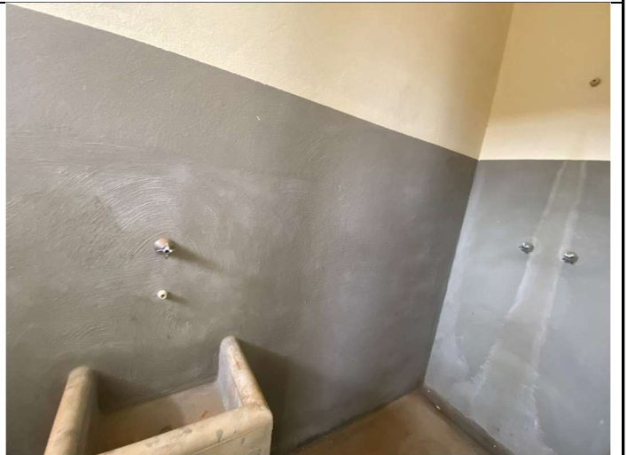
Foto 10 - Visão geral de banheiro do alojamento coletivo
