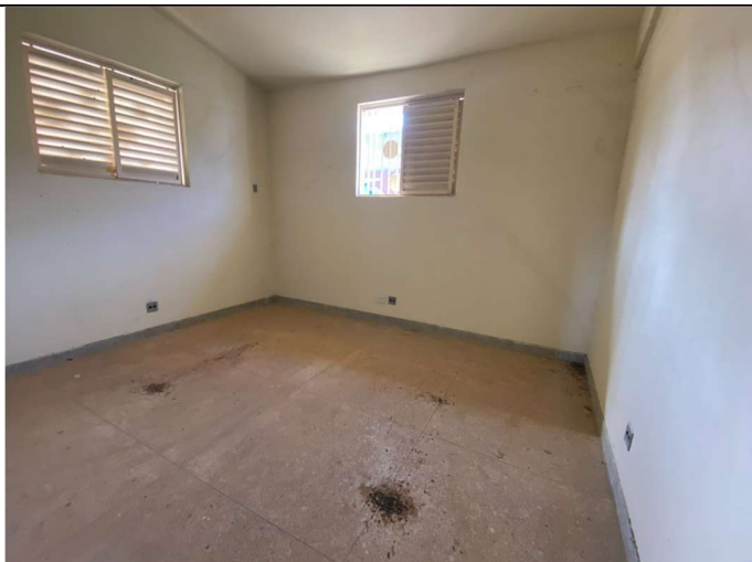
Foto 02 – Sala de apoio técnico
