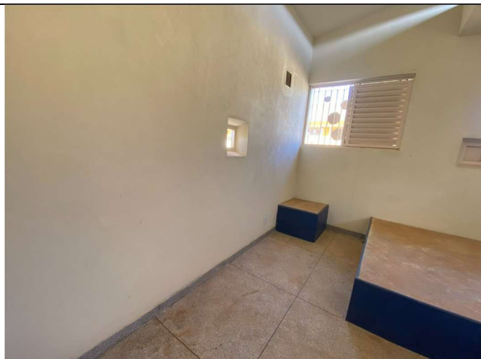
Foto 04 – Visão geral de um dos alojamentos
