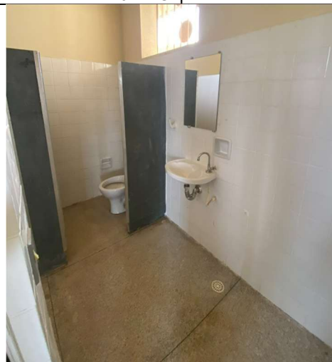
Foto 04 – Banheiro do setor
