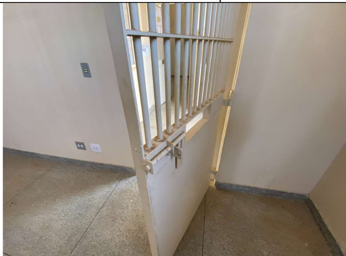
Foto 03 – Ferrolho voltado para dentro das salas
