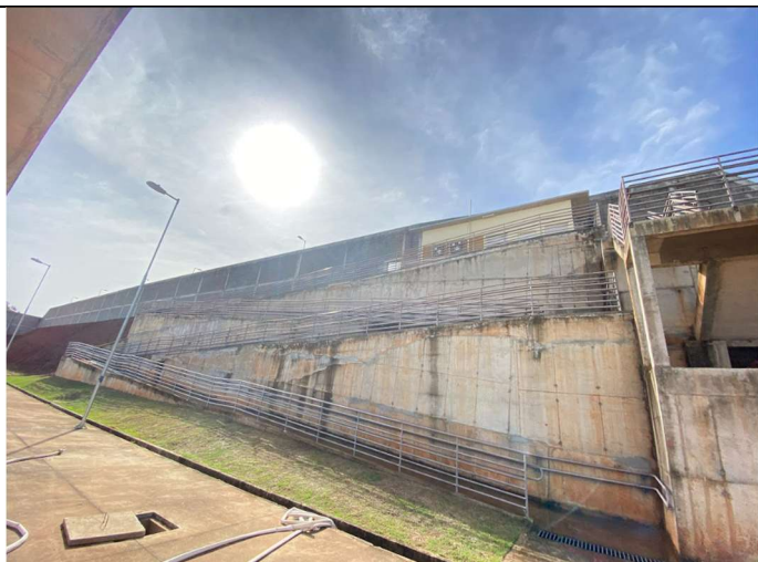
Foto 05 – Visão geral de rampa entre os platôs
