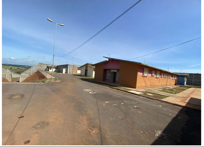
Foto 02 – Visão geral do platô superior da Unidade
