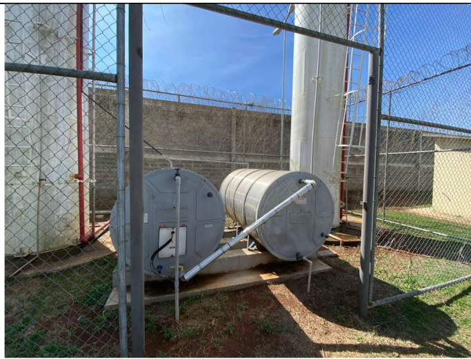
Foto 02 – Portão para área de boiler e reservatório de água a ser reinstalado
