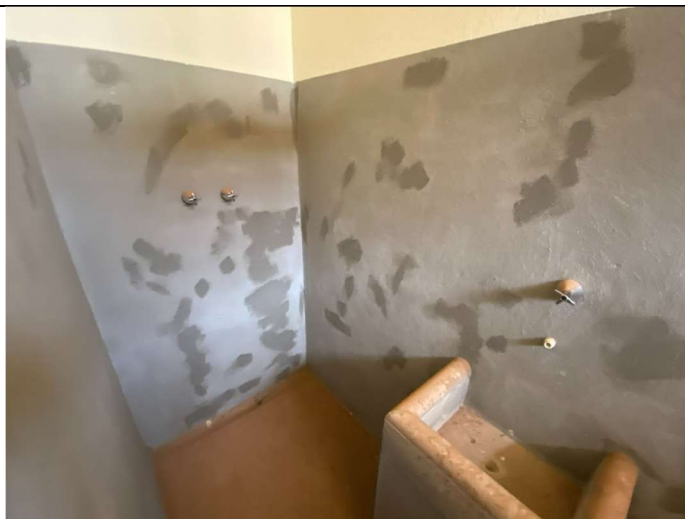
Foto 13 - Visão geral de banheiro do alojamento
