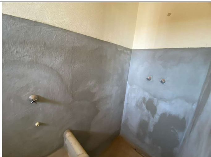
Foto 10 – Visão geral do banheiro no bloco
