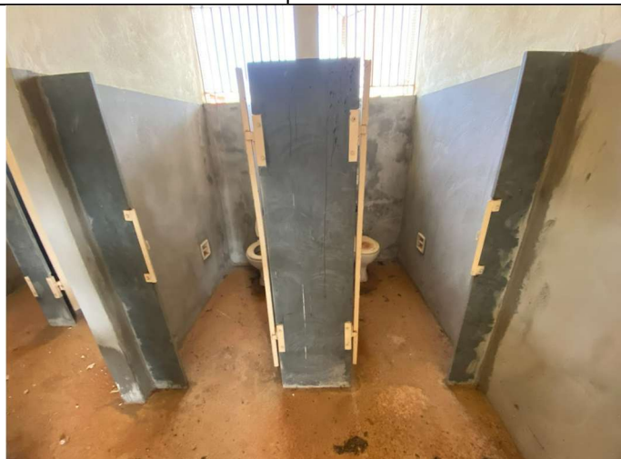
Foto 04 – Visão de box de banheiro
