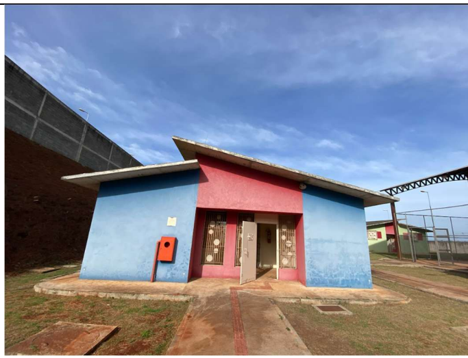
Foto 04 – Fachada do prédio
