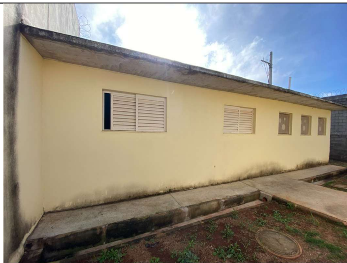
Foto 06 – Prédio da guarda externa
