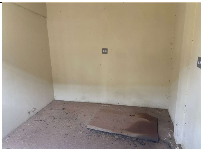
Foto 14 – Sala de atendimento
