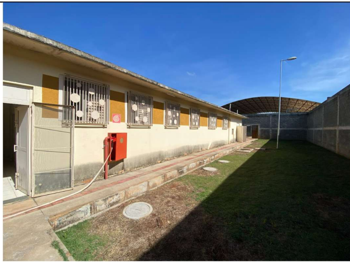
Foto 03 – Fachada externa do setor
