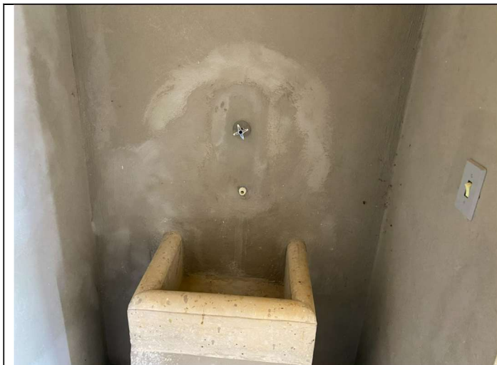
Foto 07 – Banheiro do setor
