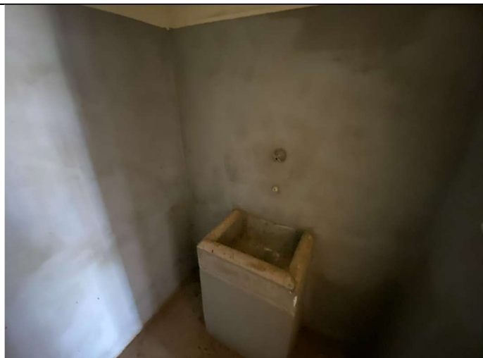
Foto 07 – Banheiro do prédio
