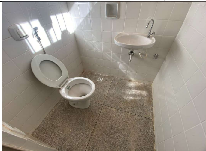
Foto 04 – Banheiro do setor
