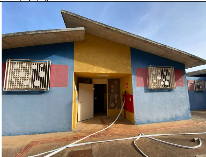
Foto 01 - Fachada do prédio
