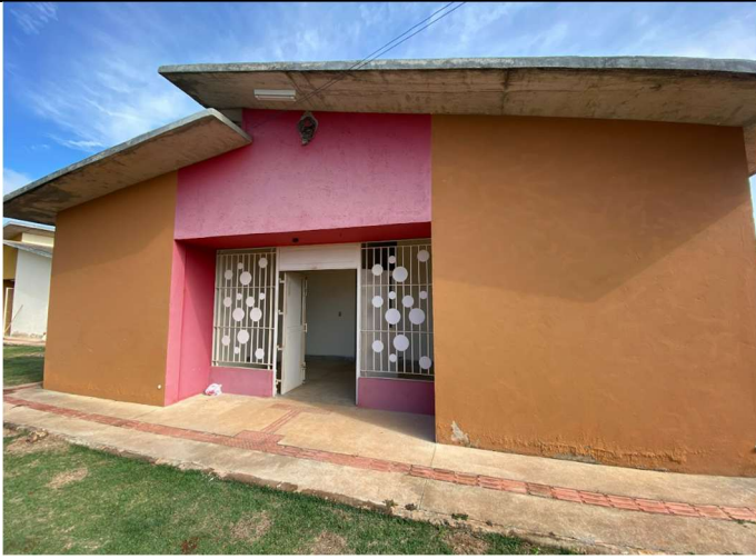
Foto 01 – Fachada do prédio
