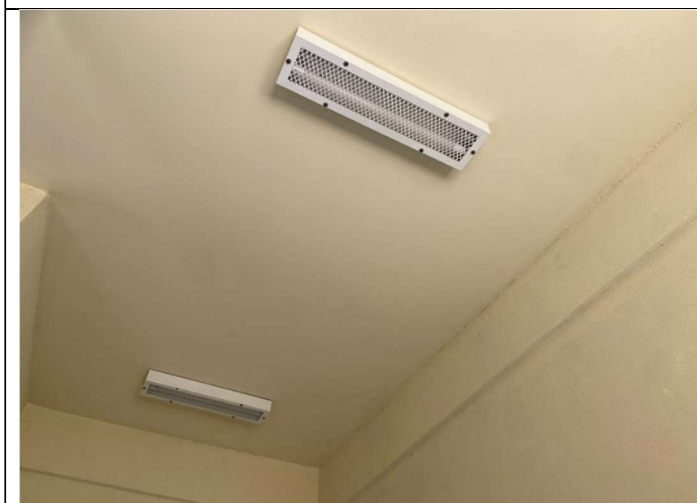
Fotos 15 e 16 – Luminárias com e sem proteção nos alojamentos
