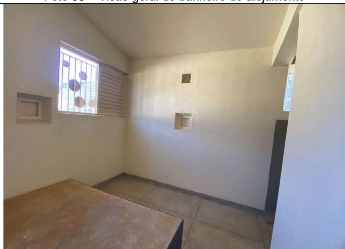
Foto 05 – Visão geral de um dos alojamentos
