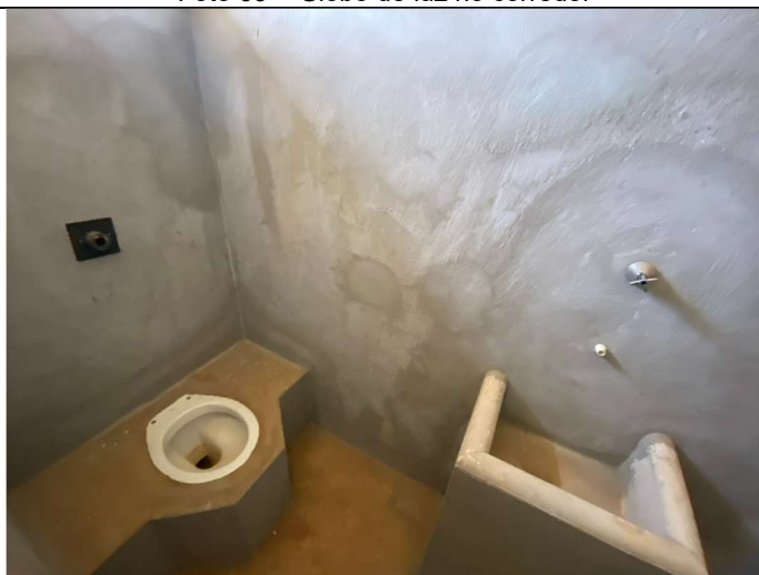
Foto 11 - Visão geral do banheiro no bloco
