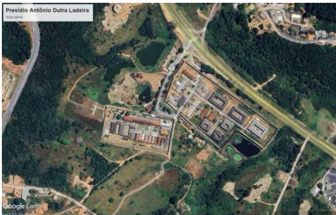
Fig. 01: Imagem aérea do Presídio Antônio Dutra Ladeira. Fonte: Google Earth Pro
